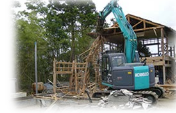
被災家屋等の解体
